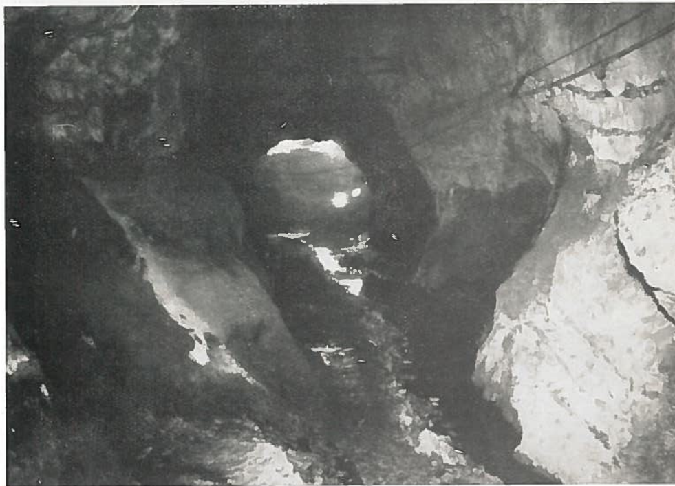
La prima galleria del Buco del Piombo vista dall'interno; al fondo, lo sbarramento caotico dei detriti franati dalla volta. (foto S. Dell'Oca)
