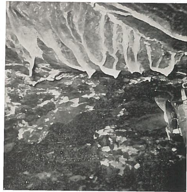
Fig. 1 - Doss delle Grave (Monte Calisio): Concrezioni a festoni pendenti dalla volta di una antica galleria di coltivazione del giacimento di galena argentifera nella formazione a Bellerophon (Foto G. Perna).
