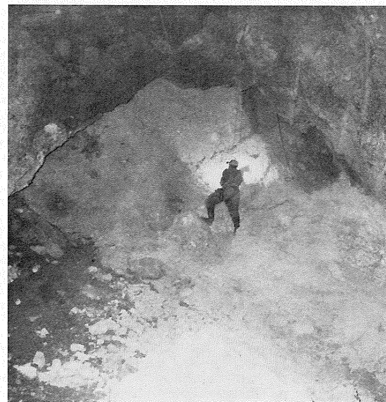
Fig. n. 42 La galleria artificiale della Cava ANIC con il cono detritico formatosi in seguito al crollo del riempimento della sovrastante Grotta del Re Tiberio. Foto G.C. Casali
