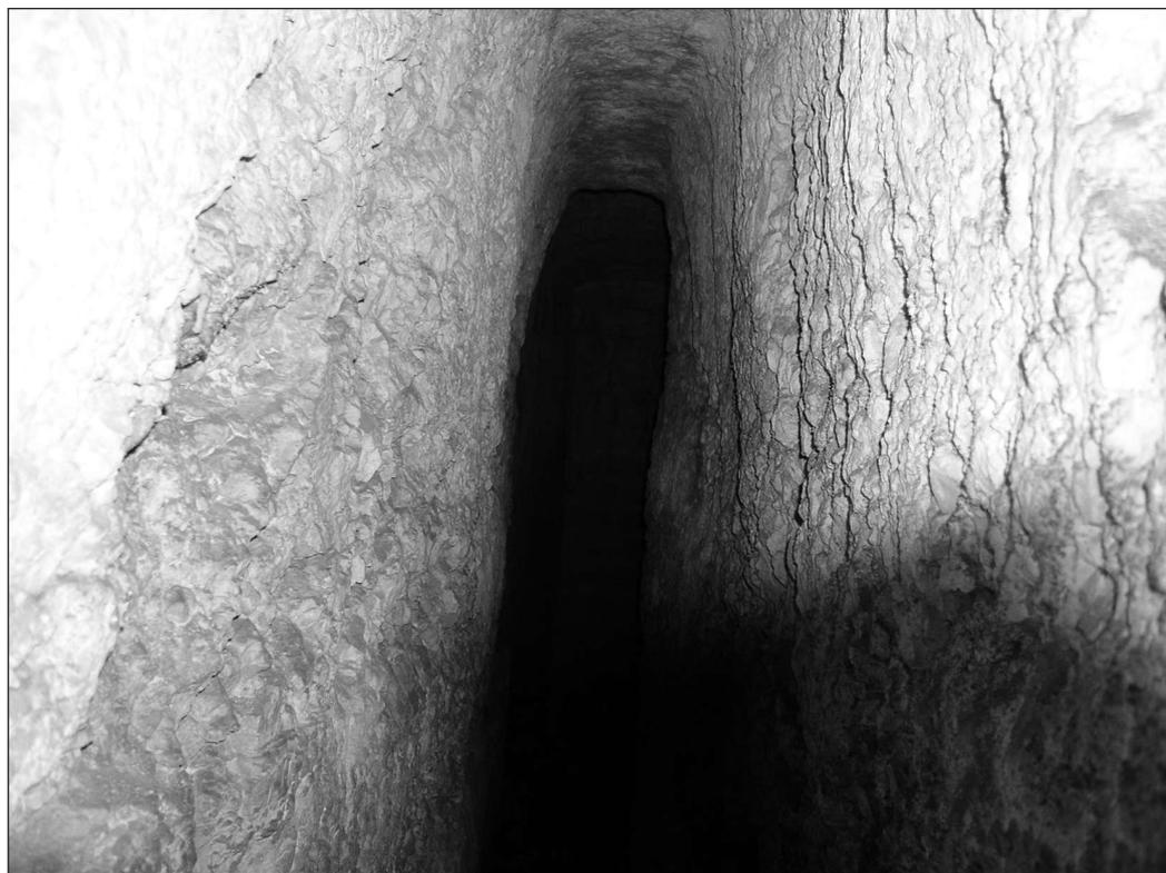
di distribuzione della risorsa idrica per il fabbisogno dei cittadini. Tale elemento architettonico ha una superficie di circa 70 mq. La cisterna ha una volumetria pari a 48.4 mc. Il serbatoio La Felicia mostra un'architettura ottocentesca. La sua funzione consisteva in una vasca di accumulo dei volumi idrici che vi affluivano
